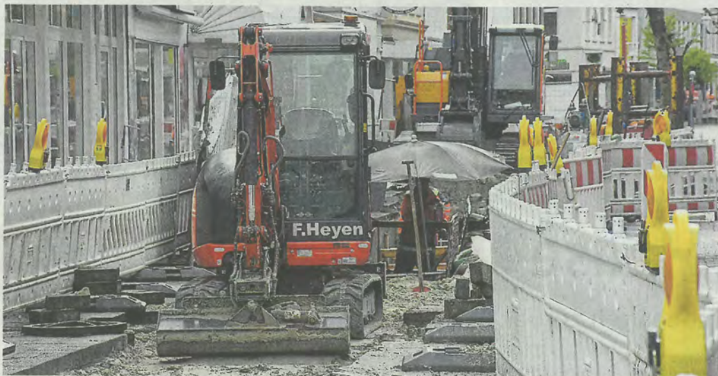
Großprojekt in der Innenstadt: Die Kanalsanierung in der Osterstraße konnte zeitlich gestrafft werden und wird zur Freude der Kaufleute früher abgeschlossen.
