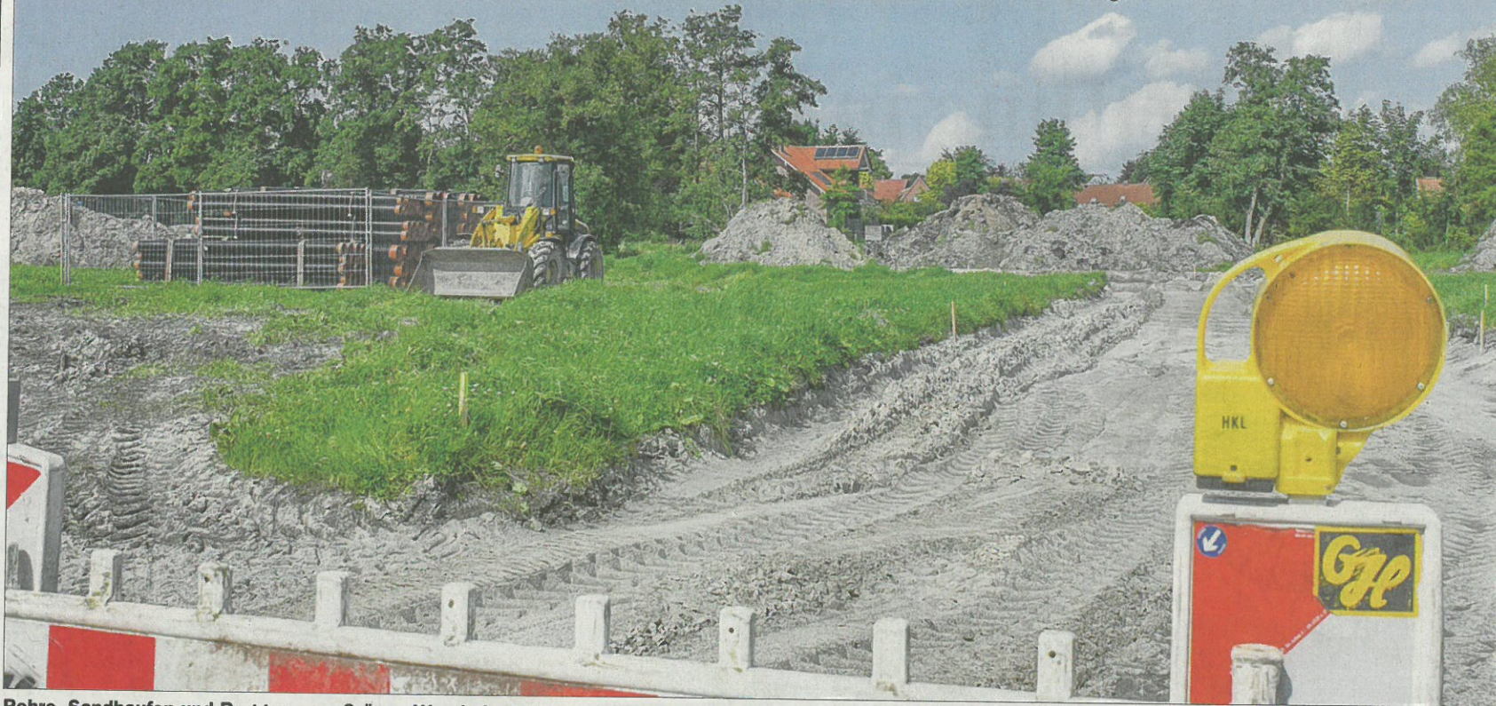
Rohre, Sandhaufen und Bagger – am Grünen Weg haben die Erschließungsarbeiten für 15 Baugrundstücke begonnen.
